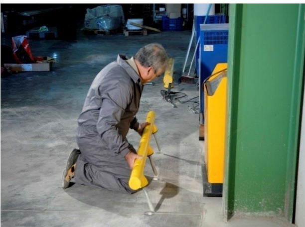
5. Aanrijbeveiliging aanpassen en invoegen
