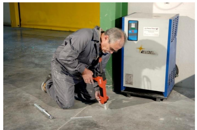
4 Vullen met Tweecomponenten Epoxyhars
