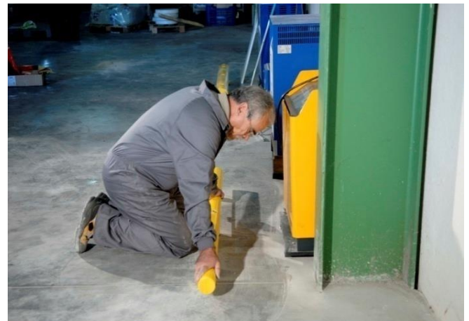
5. Aanrijbeveiliging aanpassen en invoegen
